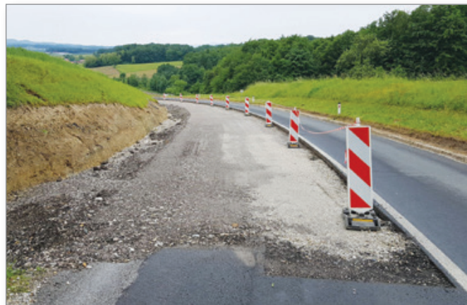
Izvedba del na obnovi regionalne ceste in izgradnja pločnika v naselju Brengova
