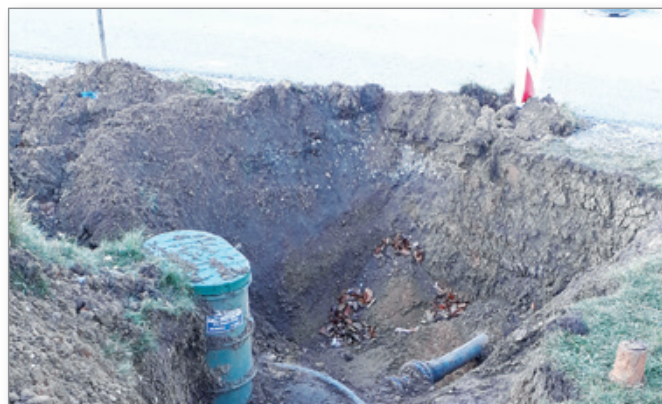
Izvedba del v naselju Andrenci in Peščeni Vrh
